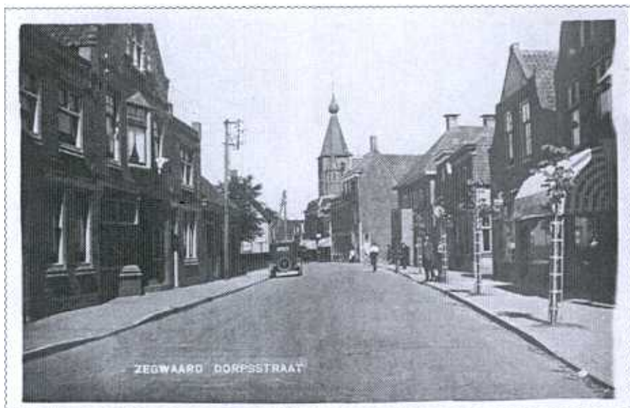
Rechts zichtbaar naast de electriciteitsmast, het spuihuisje van de Dorpsstraat, met twee dubbeledeuren
